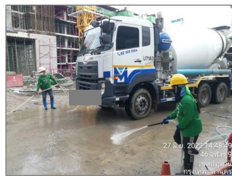
ภาพที่ 2.2-10 พื้นที่ล้างล้อรถบรรทุก
