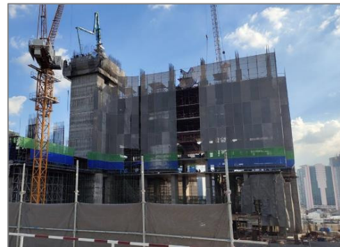
ภาพที่ 2.2-3 แนวรั้วทึบ (Metal Sheet) รอบพื้นที่โครงการ
