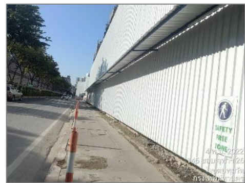
ภาพที่ 2.2-3 แนวรั้วทึบ (Metal Sheet) รอบพื้นที่โครงการ
