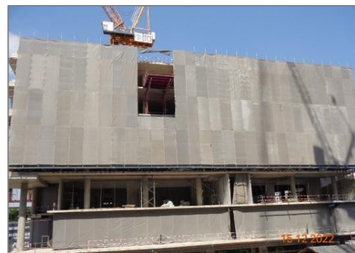
ภาพที่ 2.2-4 ตาข่ายกันฝุ่น (Mesh Sheet)
