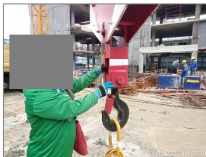
ภาพที่ 2.2-45 การตรวจสอบสภาพระบบเบรก Limit Switch สลิง เชือก อุปกรณ์การยก
