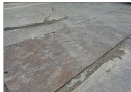
ภาพที่ 2.2-46 การปูพื้นด้วยแผ่นเหล็กบริเวณ ที่ไม่มีการปฏิบัติงาน
